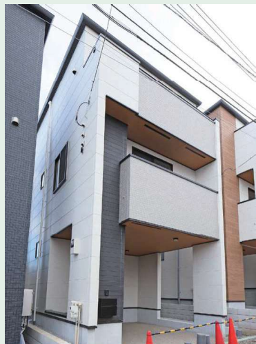
No.2現地外観
